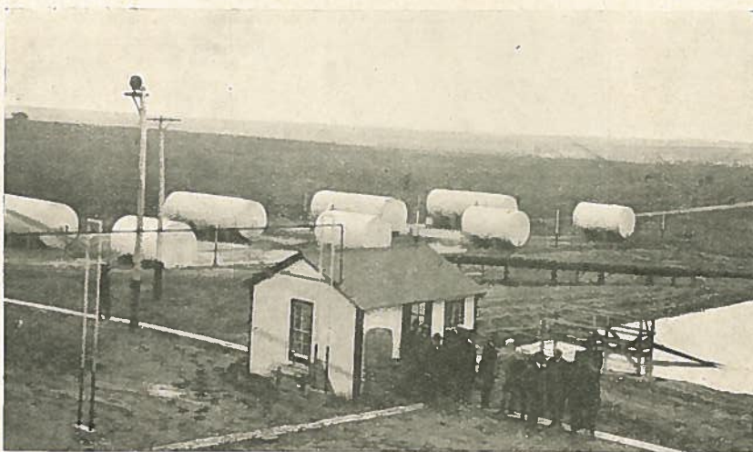
Réservoirs (Tanks) à Huile. Rangers (Texas)
