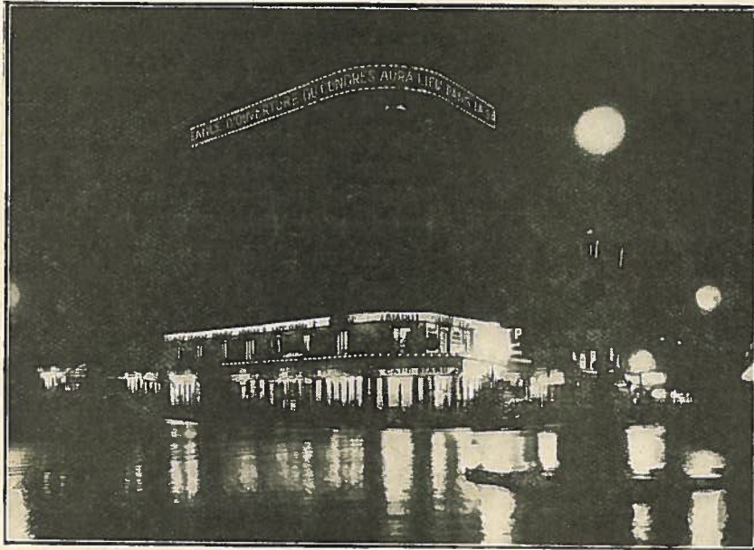
Nouveau "Journal Lumineux" sur le toit d'un Immeuble, près de la Gare St-Lazare
