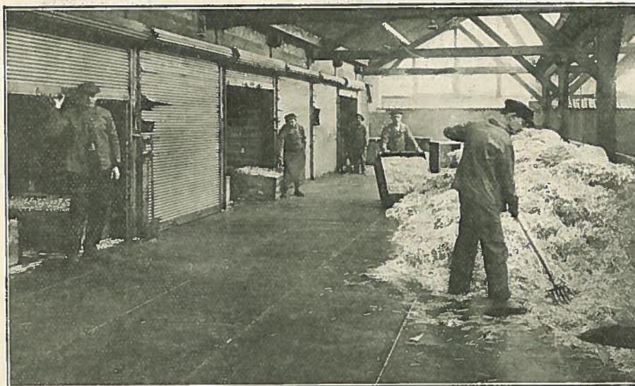
Étuves de séchage des Tiges d'Allumettes.
