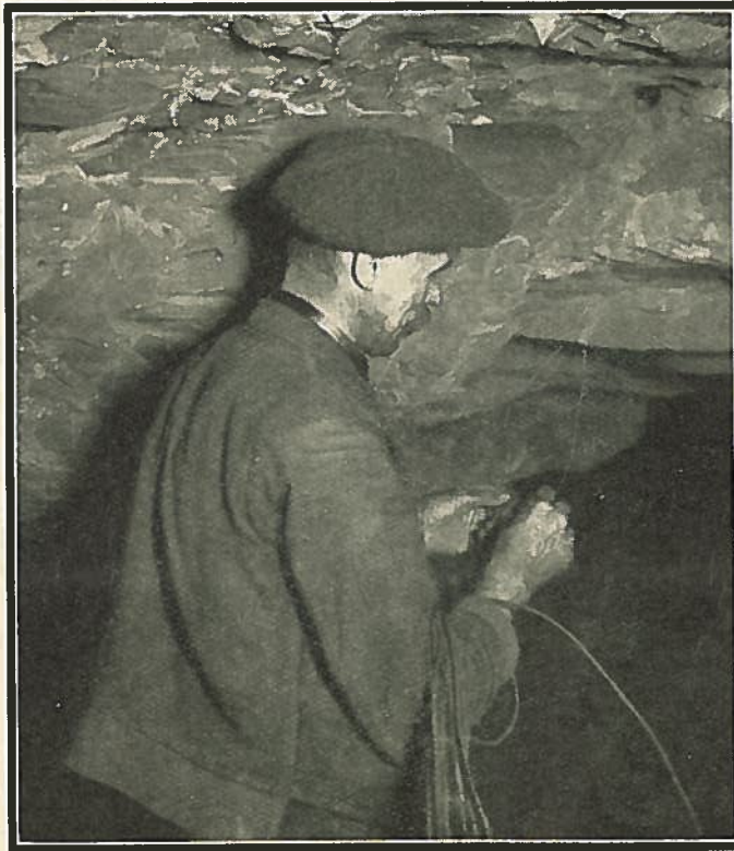
Mineur reliant l'Explosif à une Batterie de Poche.
