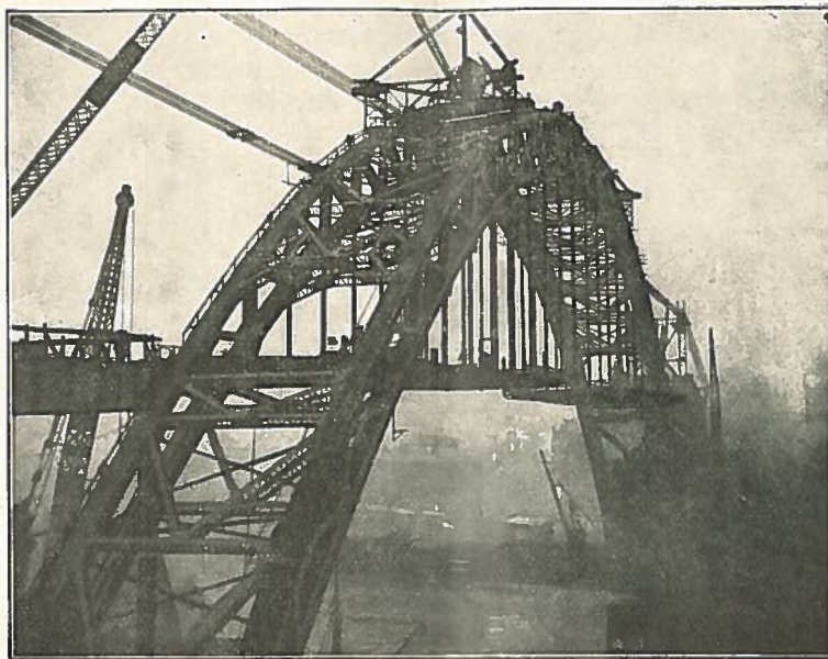
Ce Pont en Construction est celui de New-Castle. C'est une des plus merveilleuses Constructions mécaniques du Monde.
