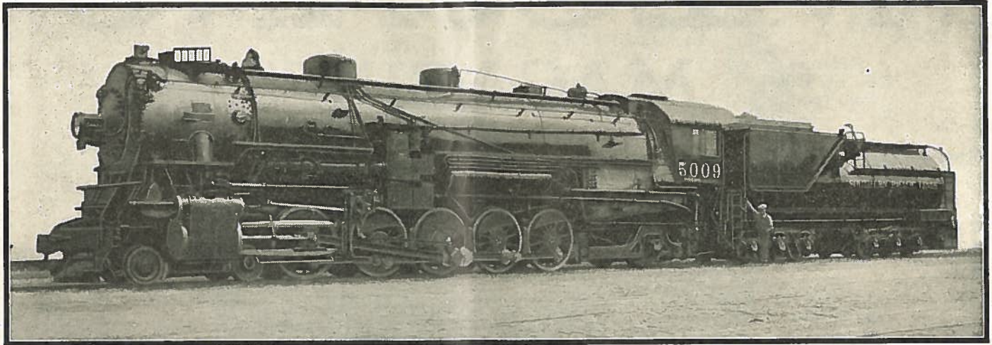
Un nouveau type de Locomotive « Pacifique », la machine roulante la plus puissante qui ait jamais été construite. Elle a trois cylindres et 10 roues motrices, 30 mètres de long et pèse 123.000 kilos !
