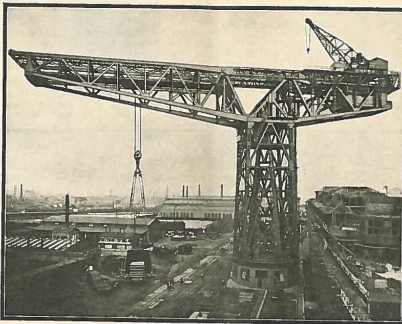
Grue Géante de 250 tonnes (Etab<sup>l</sup> Demag)
