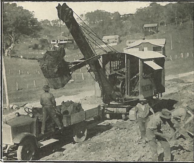
Un excavateur universel de 15 tonnes.
