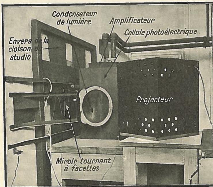
Ollébé Envers du Panneau des Cellules Photo-électriques du Poste de Transmission de l'Appareil Barthélémy. Botence et Vê
