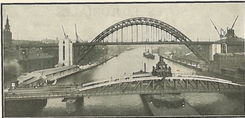
Le nouveau Pont jeté sur le Tyne entre Newcastle et Gateshead. Ce Pont est formé d'une seule arche qui mesure 160 mètres de long.
