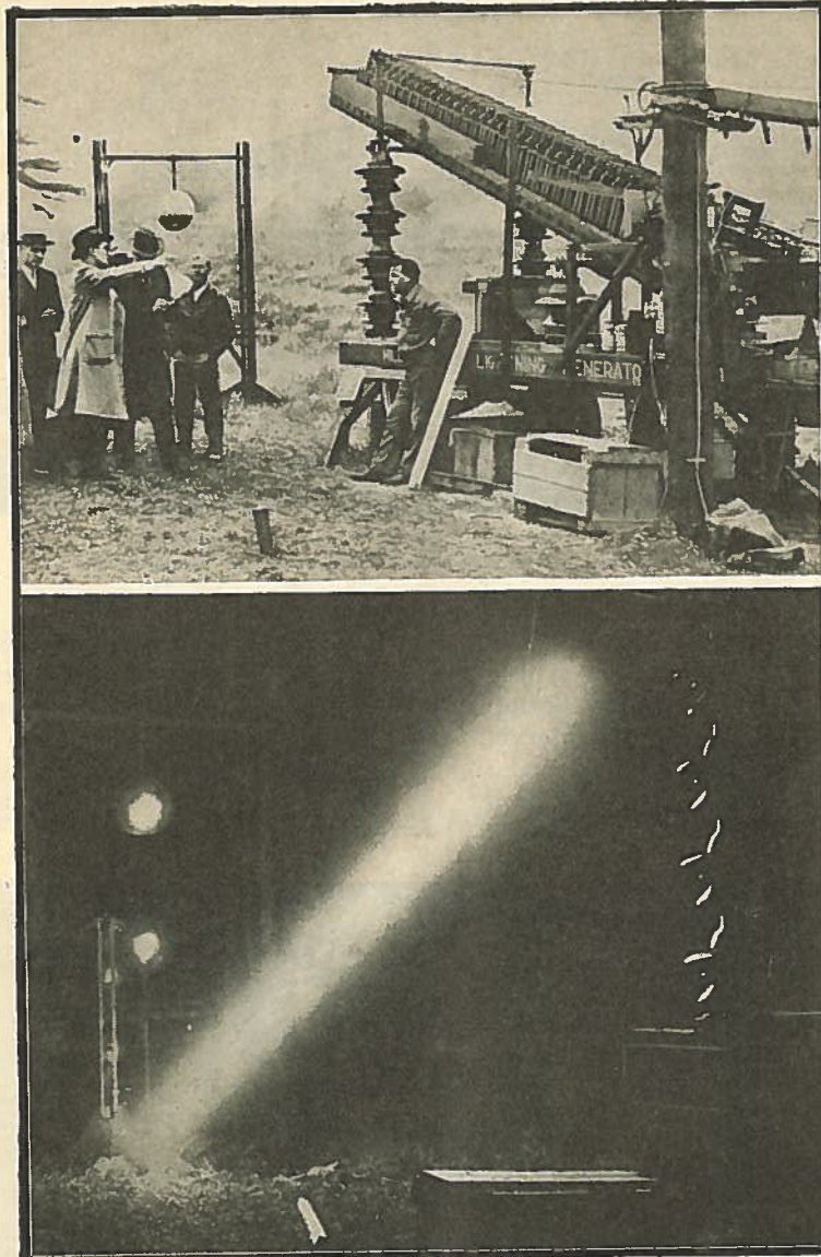
En haut: Appareil électrique produisant des éclairs artificiels. Branché sur un courant d'éclairage de 110 volts, l'appareil produit des étincelles de 1.500.000 volts. En bas: Photographie d'une étincelle obtenue au moyen de l'appareil.
