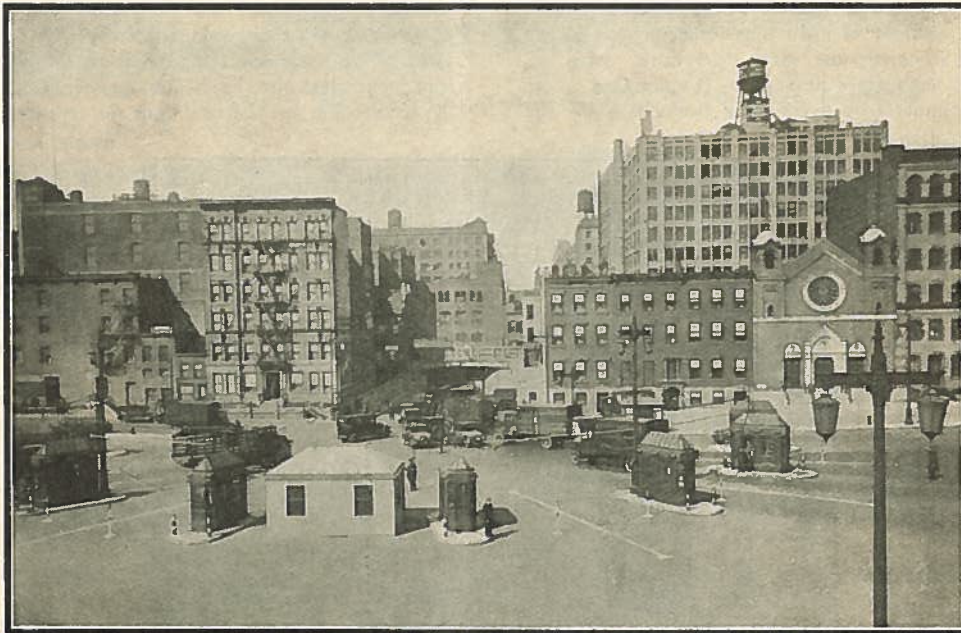
Les accès et l'entrée du Tunnel sous l'Hudson à New-York.
