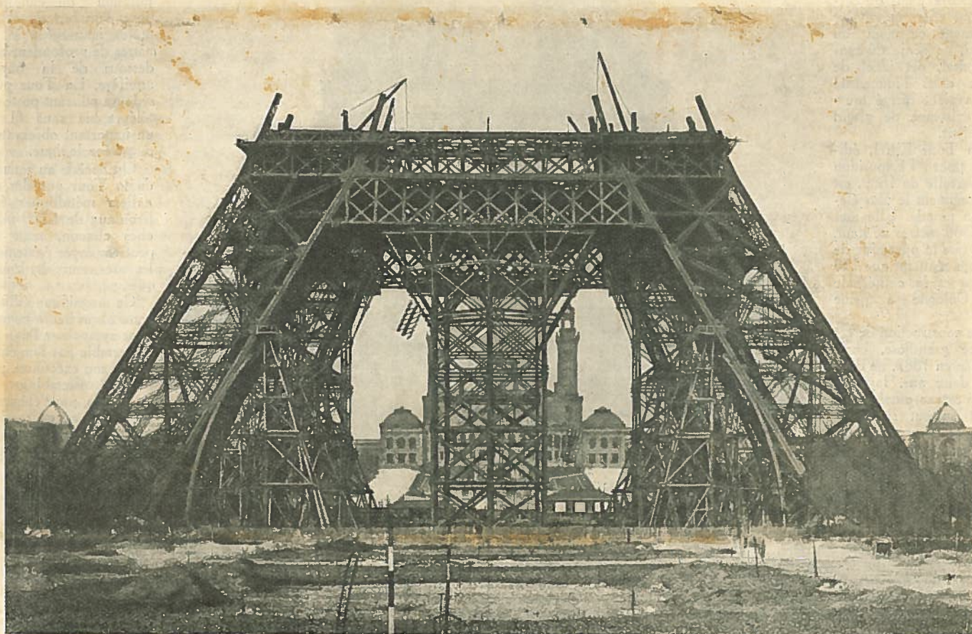
Construction de la Première Plateforme de la Tour Eiffel
